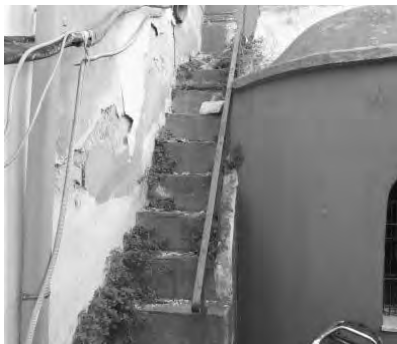
Εικ. 25. Η μικρή, στενή, κτιστή κλίμακα στη βόρεια πλευρά, που οδηγεί στον πρώτο όροφο του κωδωνοστασίου.
