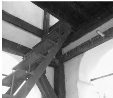
Εικ. 26. Η στενή, μεταλλική κλίμακα που οδηγεί, από τον πρώτο όροφο προς τους άλλους δύο ορόφους.
