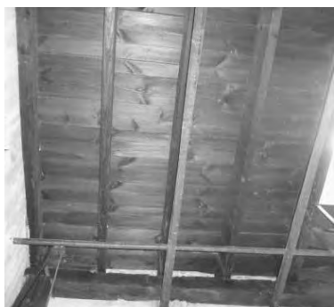
Εικ. 23. Το ξύλινο δάπεδο του πρώτου ορόφου.
