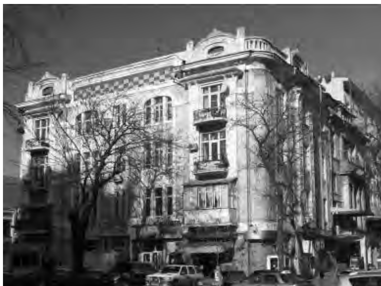
Εικ. 50. Τετραώροφο κτήριο της Οδησσοῦ, στο οποίο εγκαταστάθηκε ο εμπορικός οἶκος των Δούκα Κούλογλου και Νικολάου Σχοινά το ἔτος 1913.
