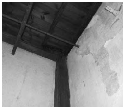
Εικ. 28. Στηρίγματα της μεταλλικής σκάλας πακτωμένα στους εσωτερικούς τοίχους του κτηρίου.
