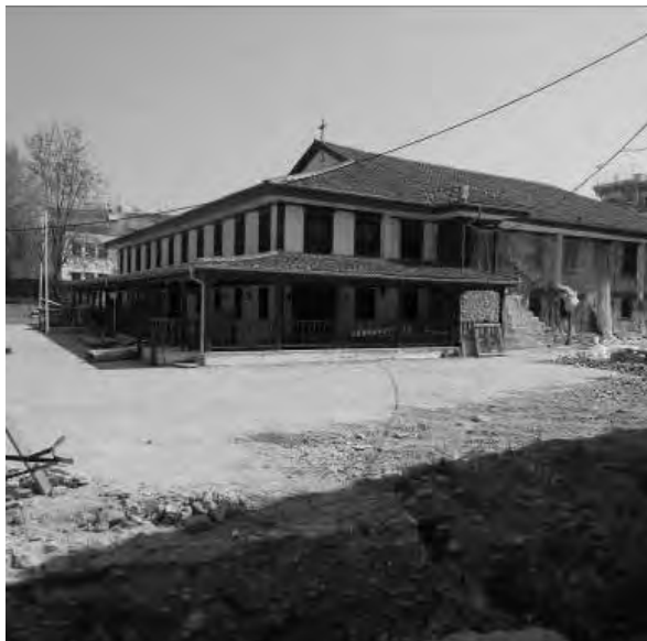
Εικ. 5. Άποψη του Μητροπολιτικού Ναού Κοίμησης της Θεοτόκου κατά τη διάρκεια εργασιών συντήρησης και αποκατάστασης (Απρίλιος 2020).
