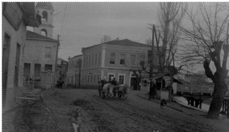
Εικόνα 11. Αποψη της οδού Βενιζέλου στην πορεία της δυτικής εισόδου της Κομοτηνής στις αρχές του 20ού αιώνα (Αριστερά διακρίνεται το Κωδωνοστάσιο και δεξιά η κοίτη του ποταμού Μπουκλουτζιά όπου σήμερα η οδός Δημοκρίτου).
