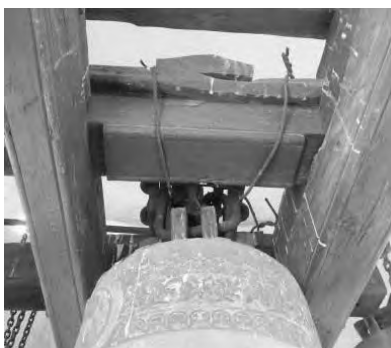
Εικ. 29. Απόληξη του φέροντος ξύλινου οργανισμού στον τρίτο όροφο, όπου κρέμονται οι έξι καμπάνες του Κωδωνοστασίου.
